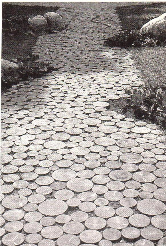
Pavimentazione ottenuta con l'accostamento di tronchi di albero di sezioni diverse
